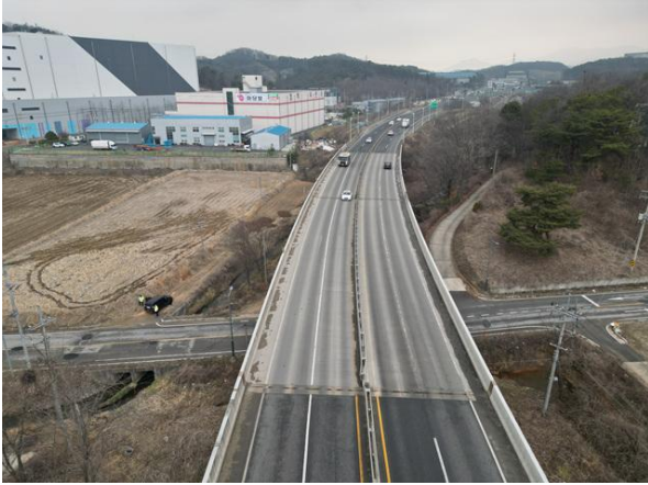
교량 상부 전경
