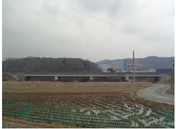
교량 측면 전경
